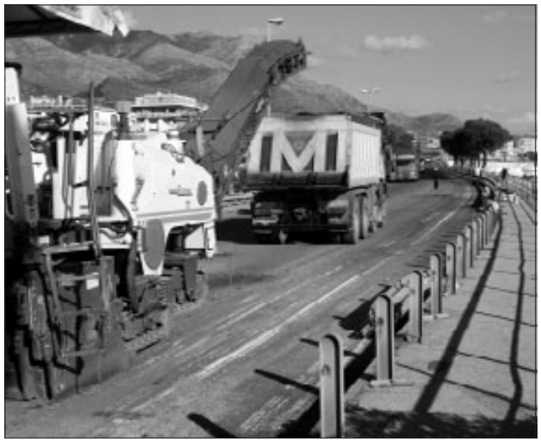
I lavori sul viadotto a torre di Mola
